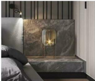
Тумба Из ГКЛ облицованная керамогранитом / ширина возле шкафа 800 мм и более видимая часть / о /высота тумбы 820 мм/ 250 мм от пола до столешницы , плинтус гкл под покраску
