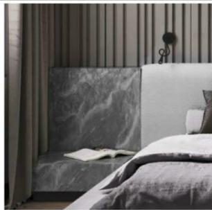
Тумба Из ГКЛ облицованная керамогранитом / ширина возле окна 600 мм / отступ от окна 150 мм для штор /высота тумбы 820 мм/ 250 мм от пола до столешницы , плинтус гкл под покраску
